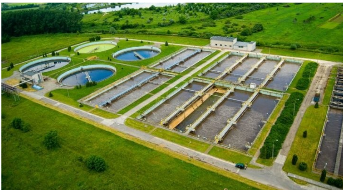
Rys. Nr 7 Zakład Oczyszczalni Ścieków w Tarnowie ul. Czysta 14
